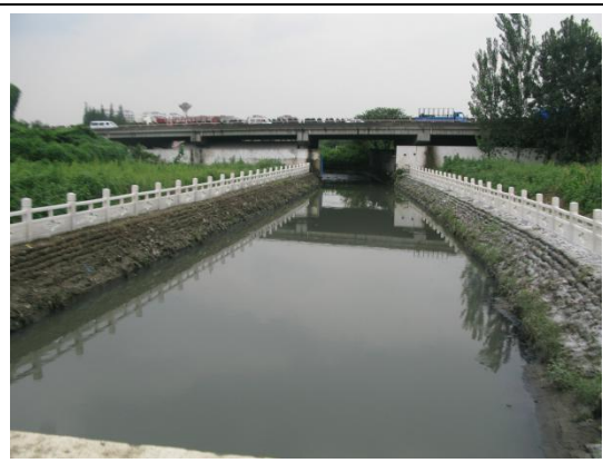
武侯区黄堰文昌段河治理后
