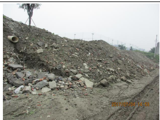
道路施工覆盖河道 武侯区苏坡六斗渠（2017.7.4）
