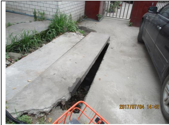
水泥板下的河道 武侯区苏坡四斗渠（2017.7.4）
