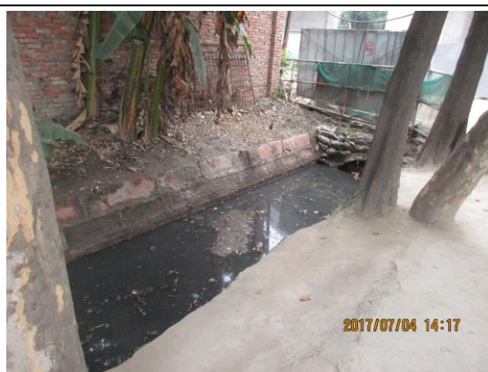
部分变为排污渠 武侯区苏坡六斗渠（2017.7.4）
