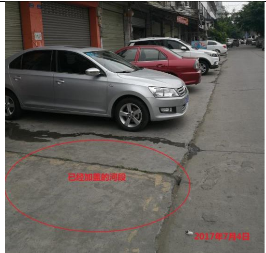
已经完全被覆盖的河道 无名小渠（2017.7.4）
